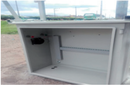
Figura 21. Vista interior Estructura
