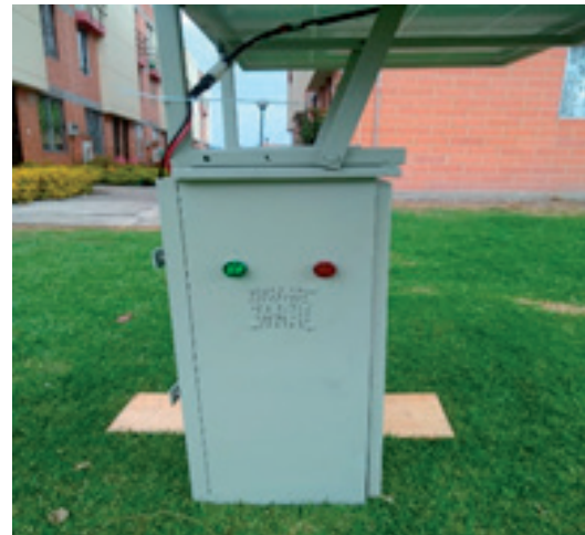
Figura 24. Vista Lateral derecha Estructura
